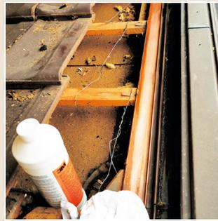
Reinigen und Entfetten der Klebefläche mit 3M VHB Oberflächenreiniger.
