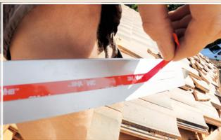
Schutzfolie von 3M Montageband anlösen, **Marder Protect™** Profil am Eindeckrahmen ausrichten und andrücken.
