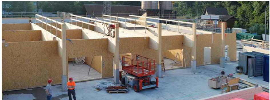
Verschraubungen von Beplankungen an Fertigelementen.
