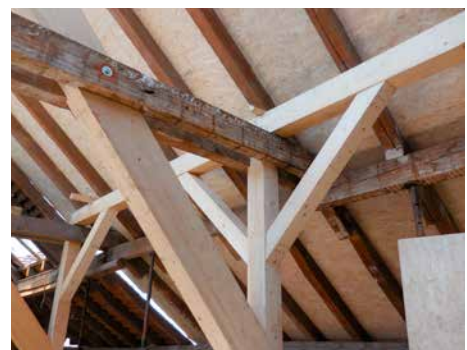
Die DA-Holzbauschrauben sind auch bei Sanierungen sehr vielseitig einsetzbar, z. B. bei seitlichen Verstärkungen von Balkenlagen oder deren Aufdoppelungen gegen das Durchbiegen.
