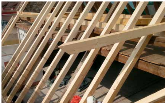
Sichere Verbindung von Sparren- / Pfettenverbindungen oder Anschlüsse von Schiftern an den Kehl- oder Gratsparren.
