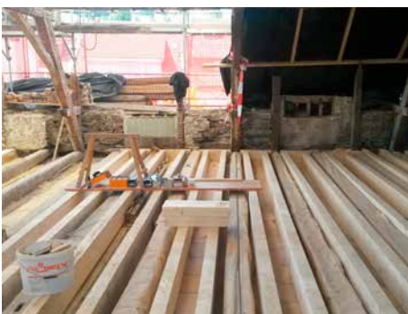
Die DA-Holzbauschrauben sind auch bei Sanierungen sehr vielseitig einsetzbar, z. B. bei seitlichen Verstärkungen von Balkenlagen oder deren Aufdoppelungen gegen das Durchbiegen.
