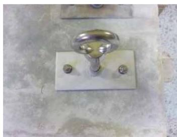
6) Visser l'anneau sur le point d'ancrage, le bloquer afin qu'il ne puisse plus être déréglé à la main.
