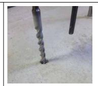
2)Die vier Bohrlöcher Ø 16 mm rechtwinklig zur Betonoberfläche 60 mm tief in den Beton bohren
