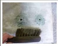
3) Den entstanden Staub von der Betonplatte entfernen (z.B. Handbesen)
