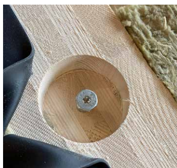
Bild 19: Beispiel Topfbohrung in einer CLT-Schmalseite
